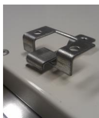
Detail eingehängte Deckenhalter
