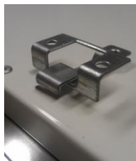
Detail eingehängte Deckenhalter
