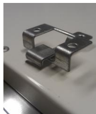
Detail eingehängte Deckenhalter
