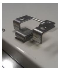
Detail eingehängte Deckenhalter
