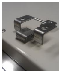
Detail eingehängte Deckenhalter
