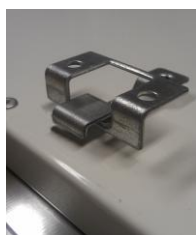
Detail eingehängte Deckenhalter
