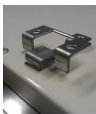
Detail eingehängte Deckenhalter
